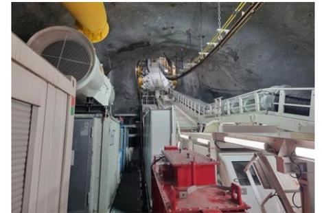
Maschinellen Vortrieb (TBM)
